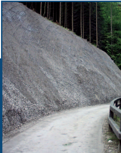
Einbau System Krismer Radweg Kastenreith
