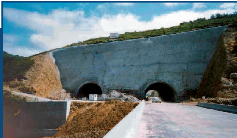
Spritzbetonbegrünung eines Tunnelportales
